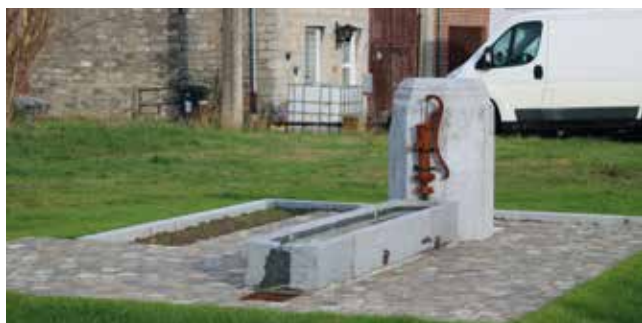
Rénovation de la fontaine à Focant
