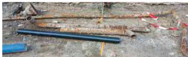
Remplacement de la tuyauterie dégradée
