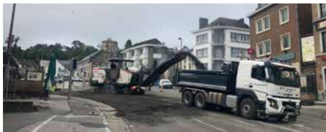
Raclage de la voirie côté carrefour
