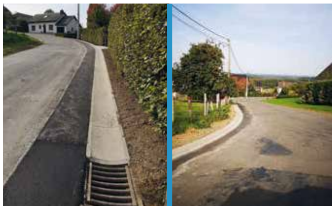
Pose de filets d'eau à Froidfontaine et à Winenne
