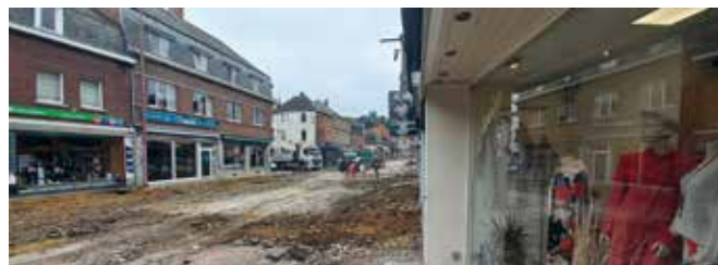
Voirie découverte de son asphalte
